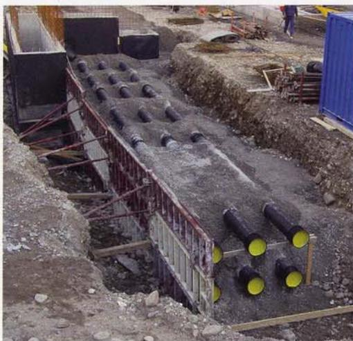
TUBI DI VENTILAZIONE E CAVI ELETTRICI posati nei solai in cemento armato (foto al centro)
