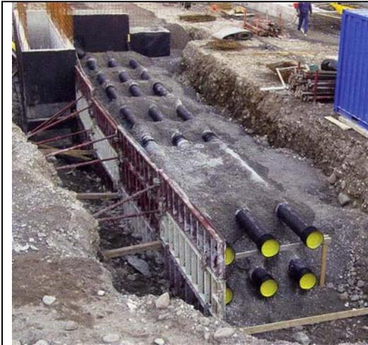
Sistema di collettori geotermici per il preriscaldamento dell'aria
